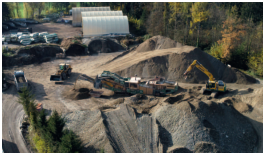
Wir bereiten Primär- und Sekundärprodukte zu neuen Baustoffen auf.
